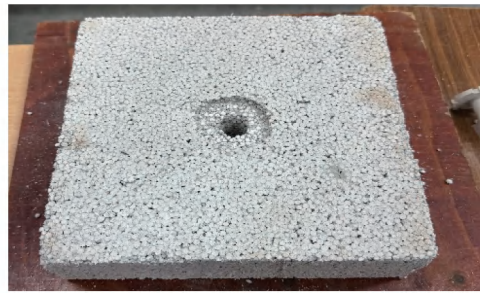
(b) 拆除连接件后热固板受拉特征照片
