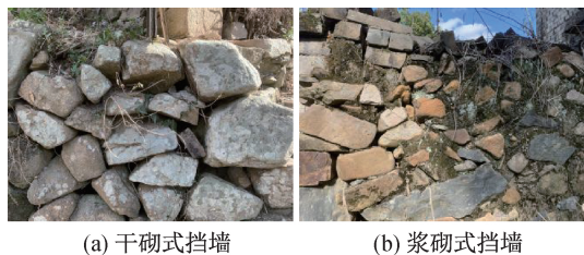
图 3 台州地区传统村落石作挡墙砌筑方式
